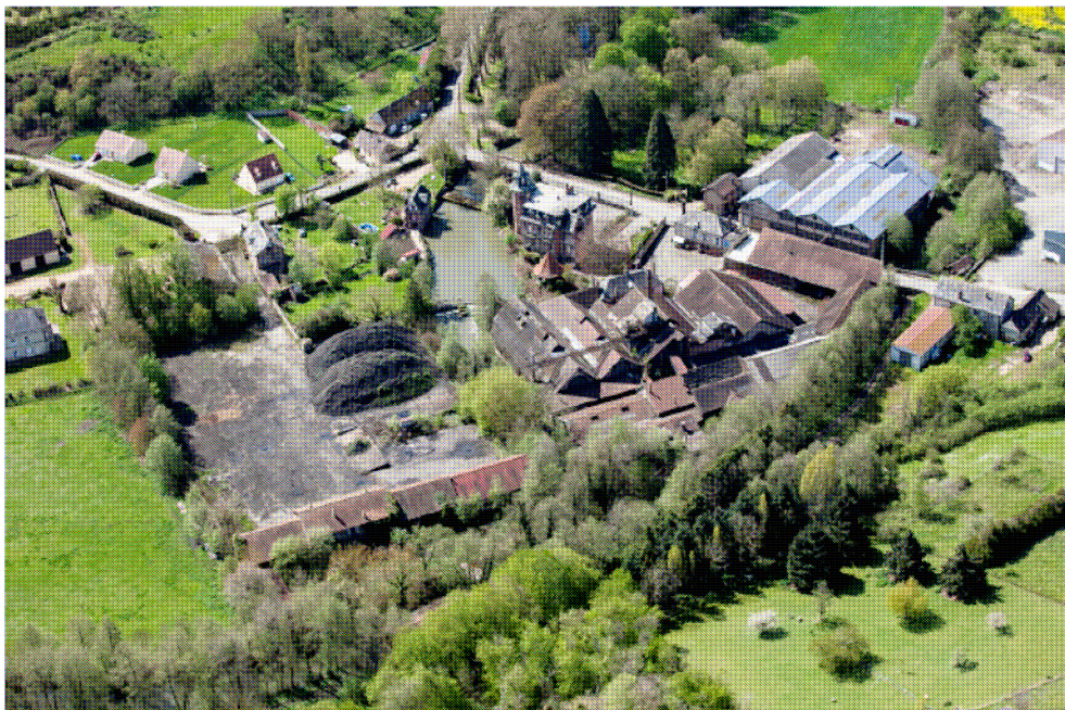
Figure 3 : Localisation du site sur photo aérienne avant démolition
